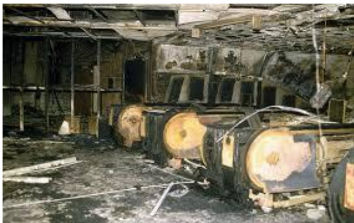
Пожар на станции метро «King's Cross».
