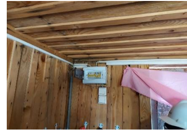
Нет однолинейной эл.схемы эл. щита.
