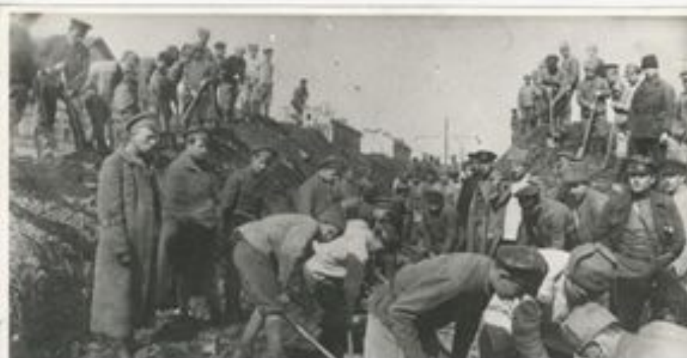
Трудармейцы за работой по прокладке рельсов
