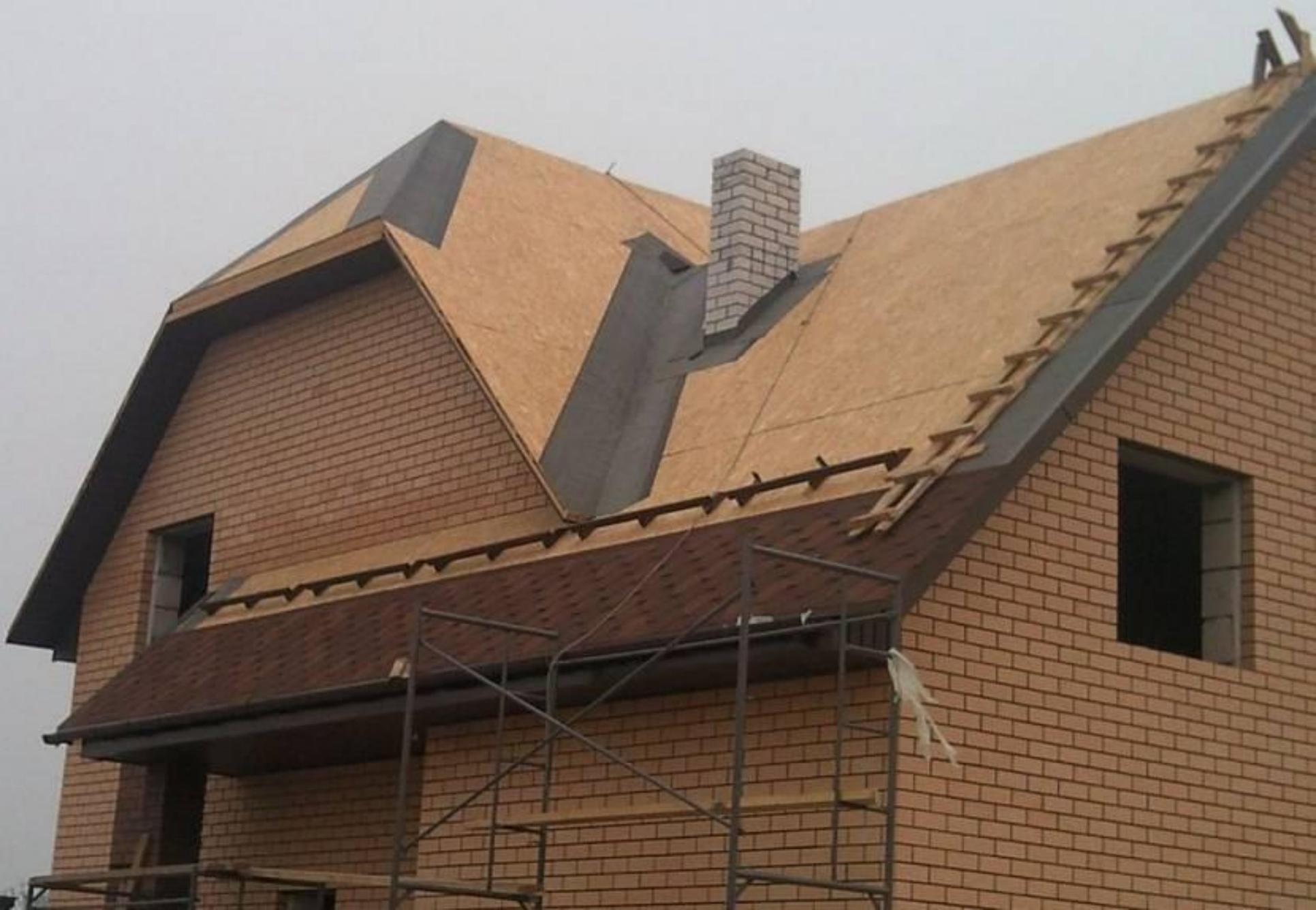
Затем укладывают покрытие на свесы вдоль карниза. При этом вертикальную свисающую полку капельника прикрывают наполовину. Далее закрывают рулонным материалом оставшуюся открытую площадь ската крыши. Здесь несколько нюансов:
