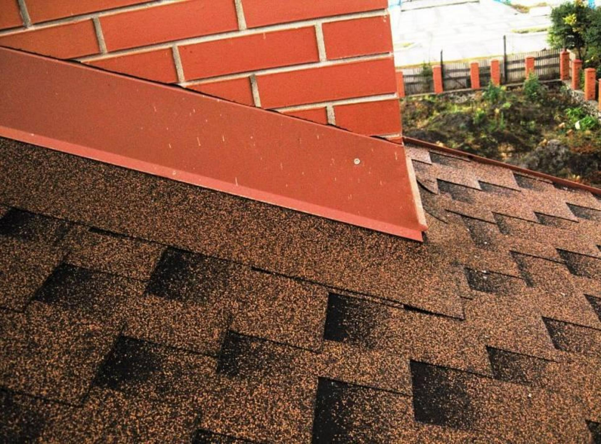
Для этого делают выкройку из ендового материала или листового железа, покрытого защитной краской. Но предварительно стенки труб закрывают по периметру листовым железом, которое к трубам крепится саморезами. Высота такого плинтуса должна составлять 30 см.
