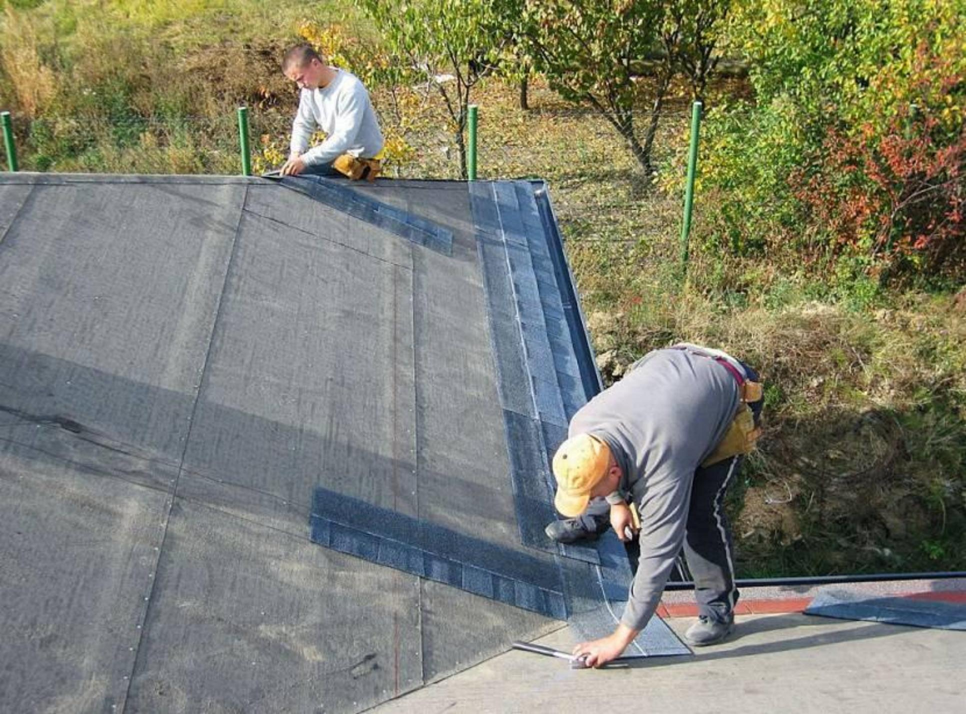
Основное требование к укладке первого ряда мягкой черепицы – отступ от нижнего края подкладочного ковра, равного 1 см. Немаловажное требование – правильное прибивание материала гвоздями. Крепежное изделие не должно врезаться в кровельный материал, оно должно его прижимать к обрешетке. Поэтому сильно прибивать или делать это косо нельзя.
