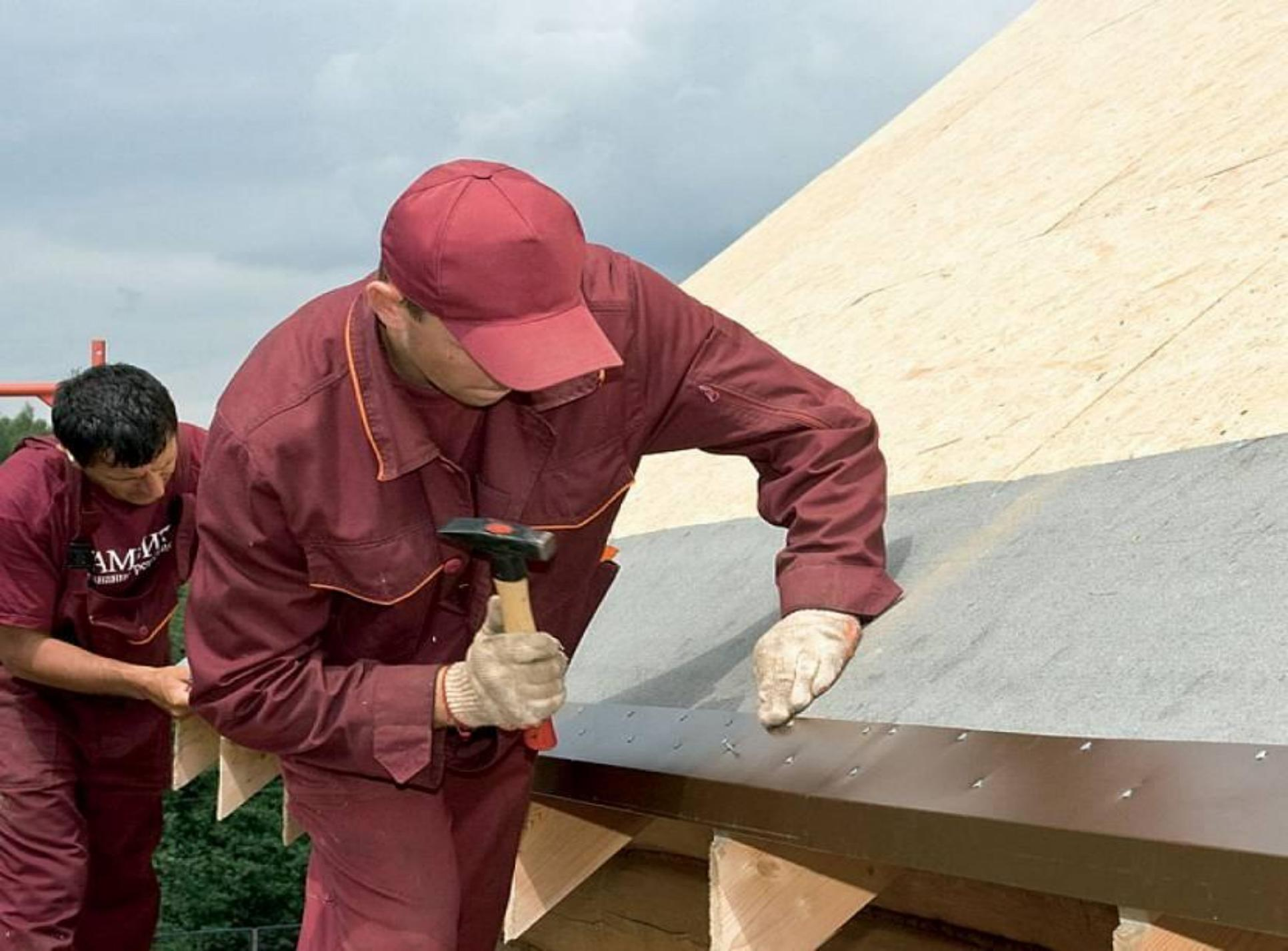
Сначала, что такое подкровельный ковер. Это рулонный материал из категории битумно-полимерных. Его укладывают на обрешетку, чтобы:
