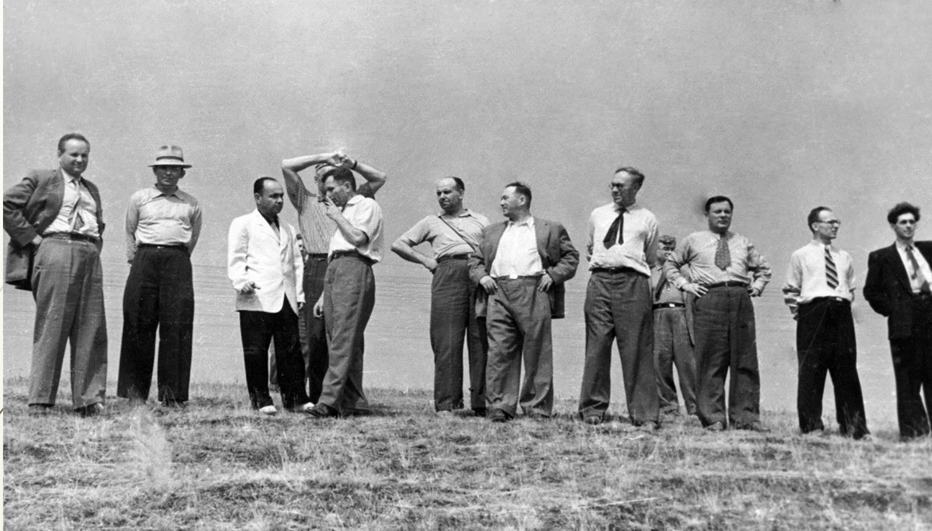
Июнь 1957 года. Осмотр площадки будущего строительства комплекса зданий Института физики (площадка будущего Академгородка)
