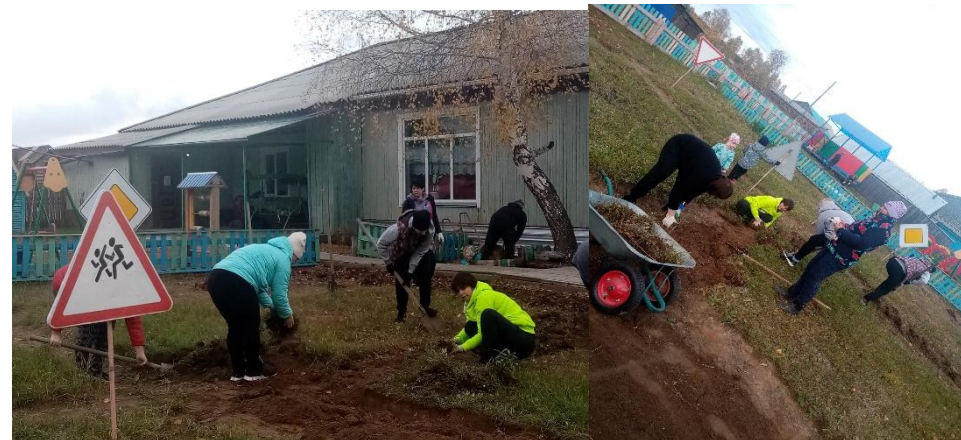
Выравнивание площадки под авто городок
