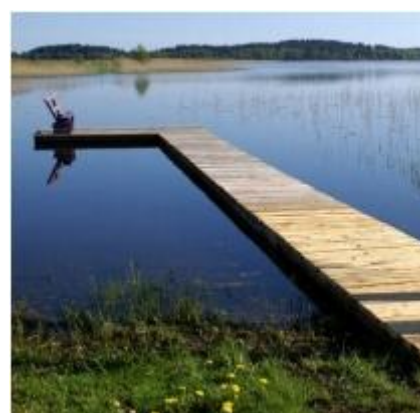
Рыбачьи мостки / причалы
