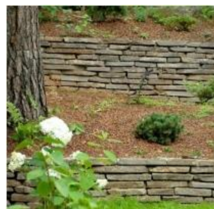
Подпорная стена на территории гребного клуба
