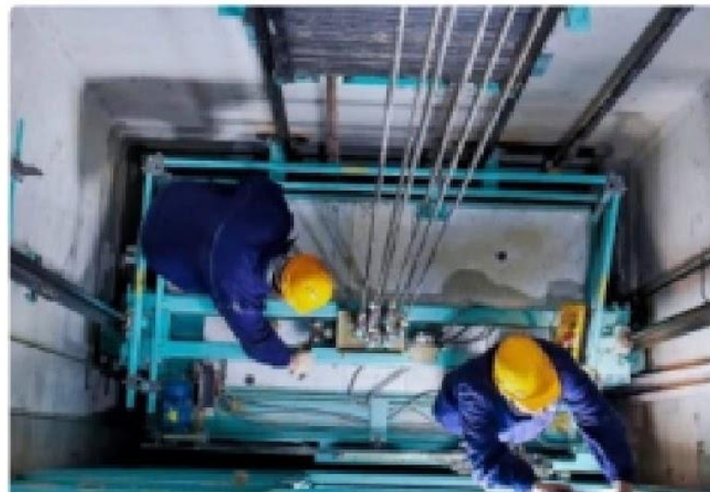
Обслуживание и ремонт лифтов
