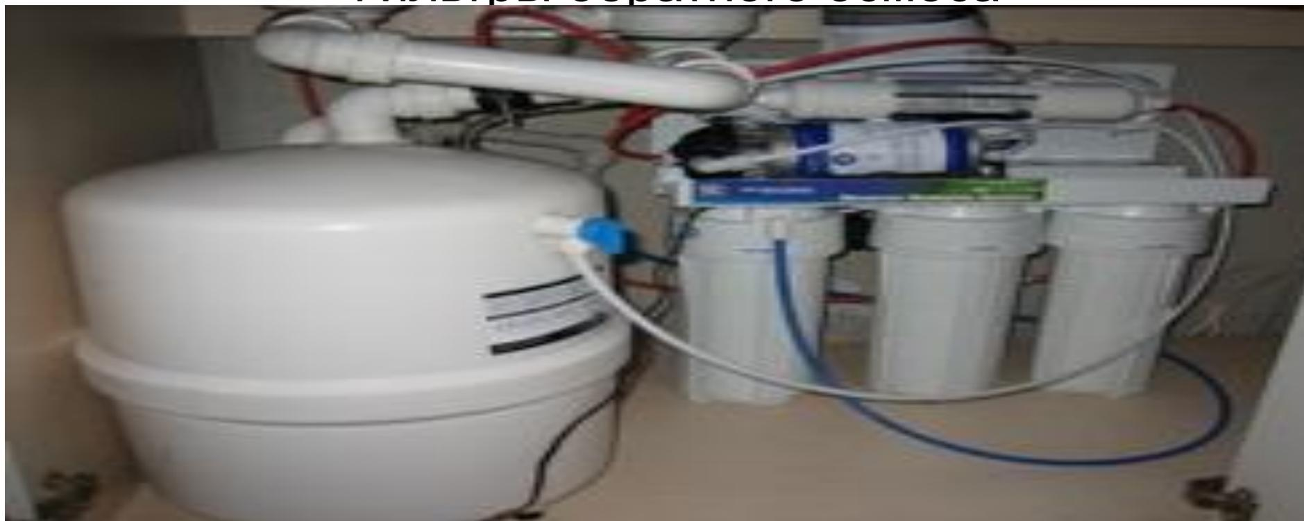
**Одна или несколько цилиндрических емкостей с различными фильтрующими элементами, а также отдельную накопительную емкость для чистой воды (в среднем 10 л). Большой ресурс, и лучшая степень очистки. Недостатком является высокая стоимость, но поскольку ресурс (до 15000 литров) и производительность фильтра (1,5-5 литров воды в минуту) высоки, то стоимость все же окупается.**
