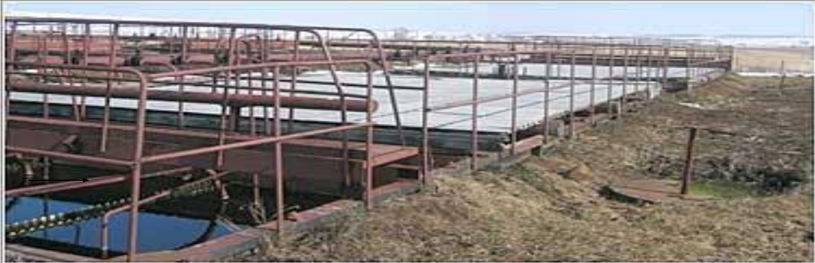
Сток в третичном отстойнике (заключительная стадия очистки)
