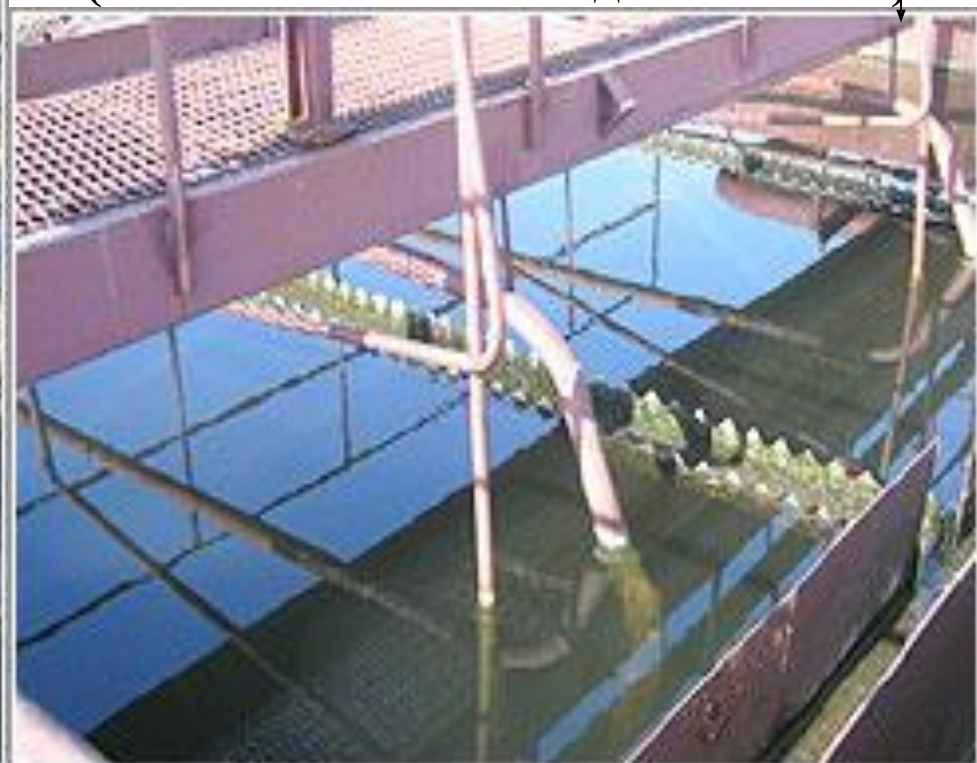
Сток в третичном отстойнике (заключительная стадия очистки)
