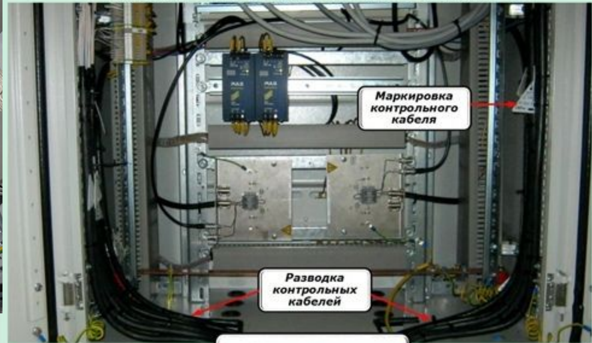
Подключение контрольных кабелей к панелям РЗА
