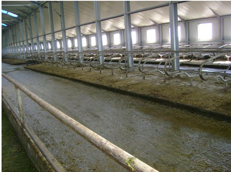
Коэффициент естественной освещенности (КЕО) определяют как отношение освещенности внутри помещения к наружной, выраженное в %. В помещениях для крупного рогатого скота он должен быть **0,4-0,8%**, в помещениях для свиней – **1,0-1,2%**.
