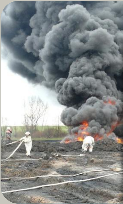
Авария на нефтепроводе
