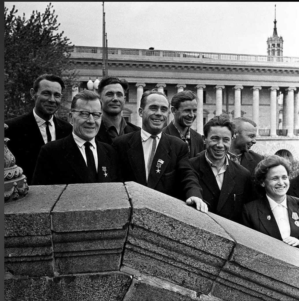
1965. Передові будівельники, що брали участь у післявоєнній відбудові Хрещатика
