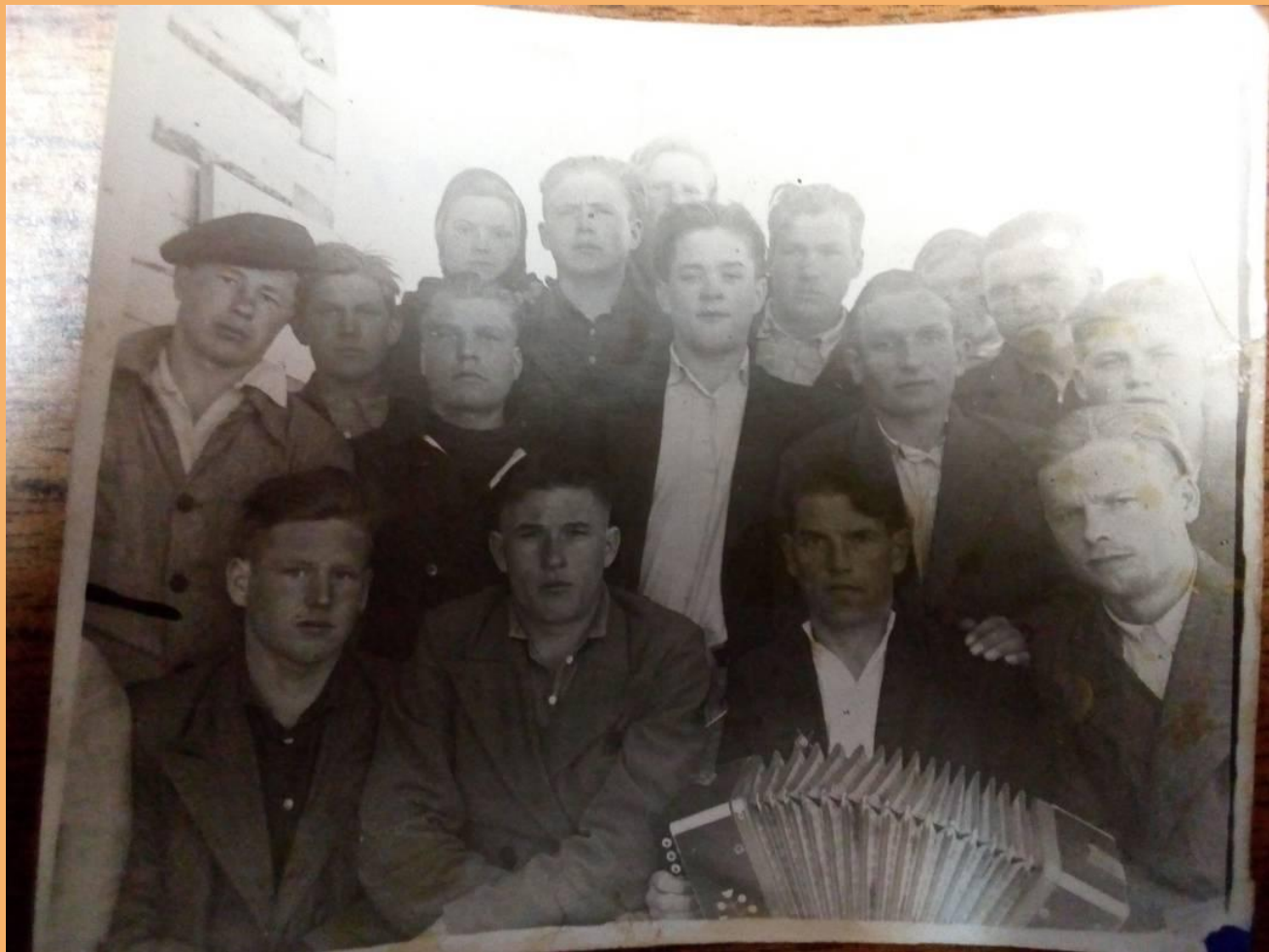
Молодежь на строительстве поселка, 1949 год. Фото из архива А.Е. Волковой
