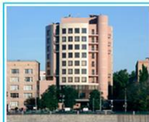
Новое здание Роспатента на Бережковской наб., 24, стр.12
