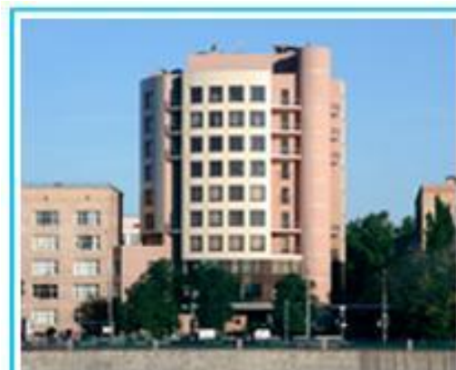
Новое здание Роспатента на Бережковской наб., 24, стр.12
