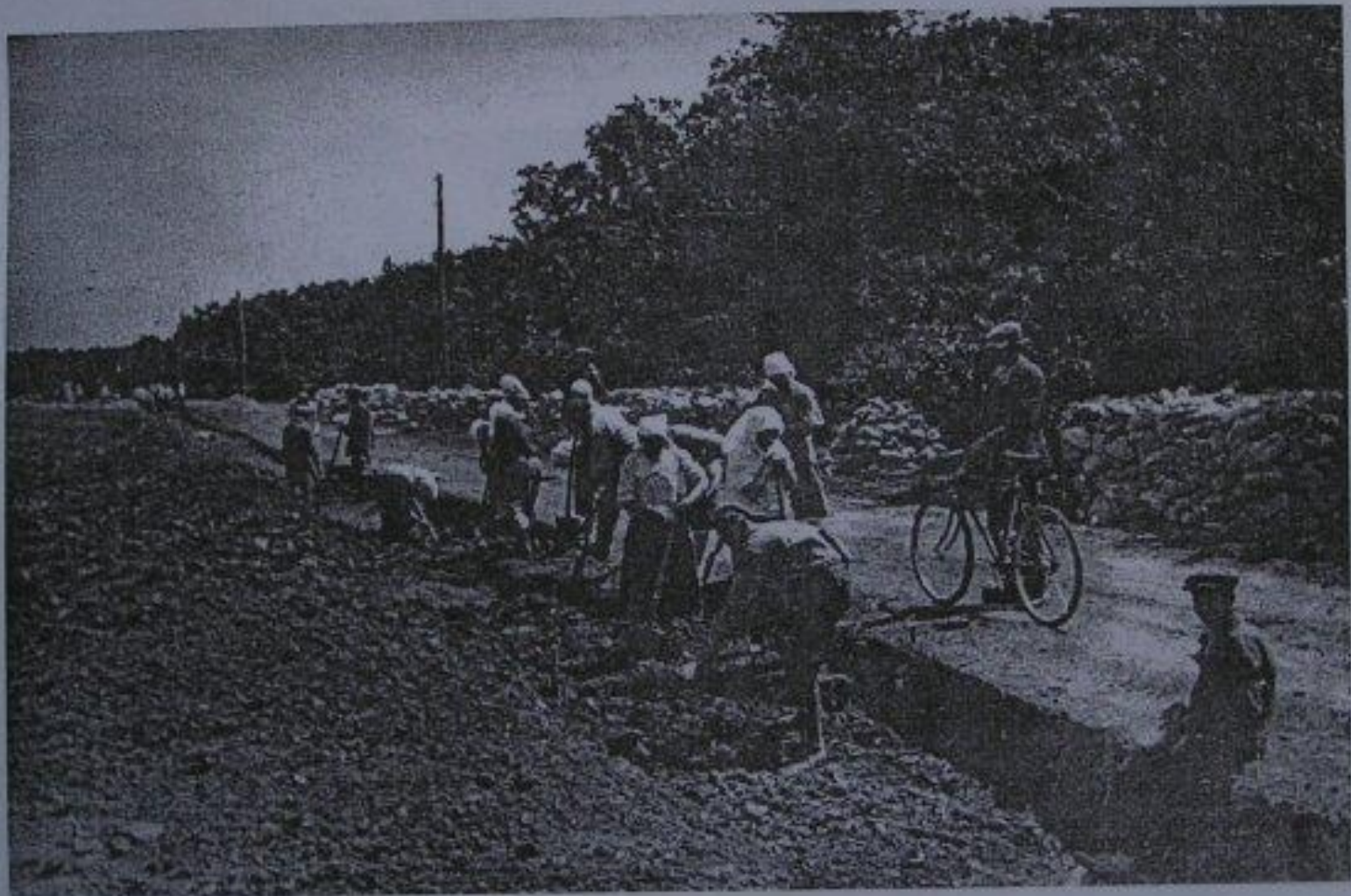
Строительство дороги Калач — Меловатка.
