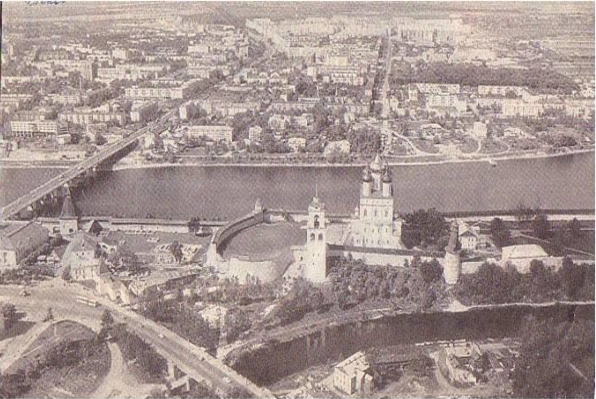
Псков. Мост через реку Великую
