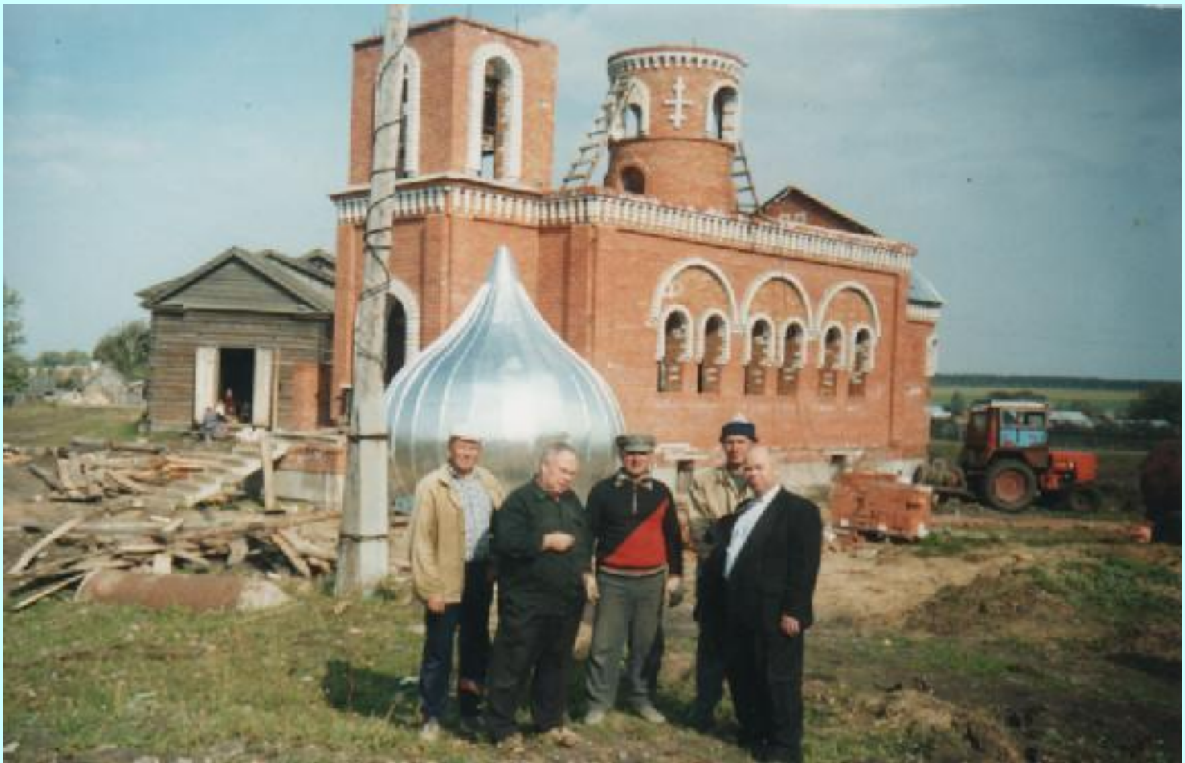
На строительстве Храма Сергея Радонежского, с. Рындино, 2003 г.
