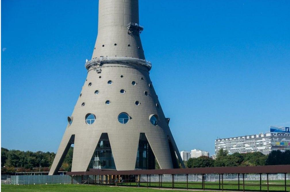
Высота Останкинской телебашни 540 метров. Ее конструкция проста, но очень надежна. Устойчивость достигается тем, что масса нижней части во много раз превышает массу мачтовой конструкции.
