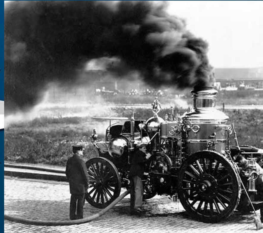
Подготовка парового насоса к работе
