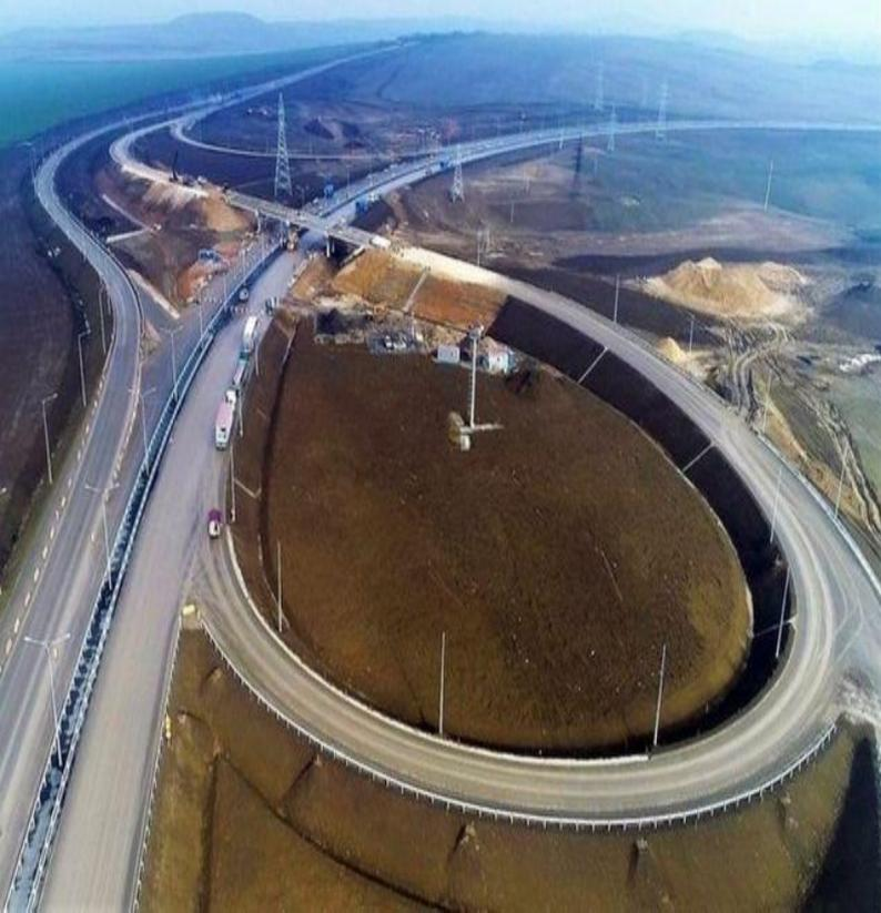
«Таврида» – нескоростная магистраль, которая относится к классу дорог обычного типа IV с шириной полосы 3,75 метра. Проложено по 2 полосы в каждую сторону. Покрытие на трассе делается из асфальтобетона.
