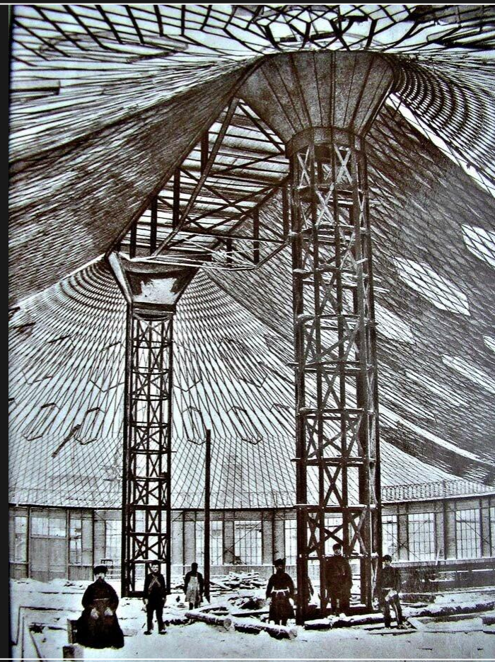
Сетчатое стальное покрытие Овального павильона В. Г. Шухова
