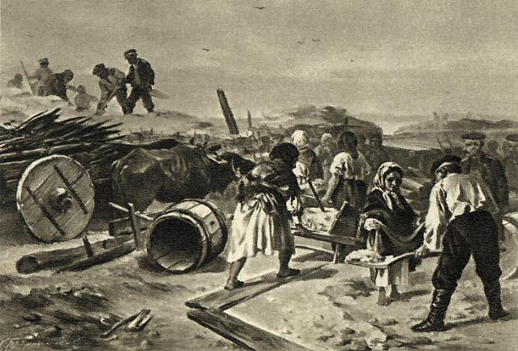
Строительство укреплений в Севастополе во время Крымской войны.
