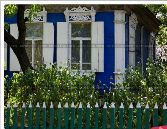
Фрагмент казачьего куреня за забором в станице Старочеркасской © Борис Панаскк / Фотобанк Лори lori.ru/97790
