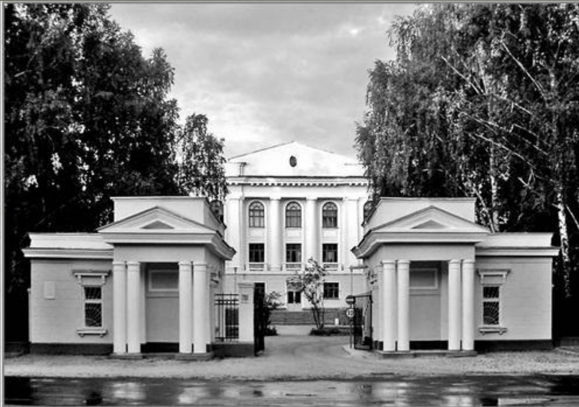
Центральная заводская лаборатория
