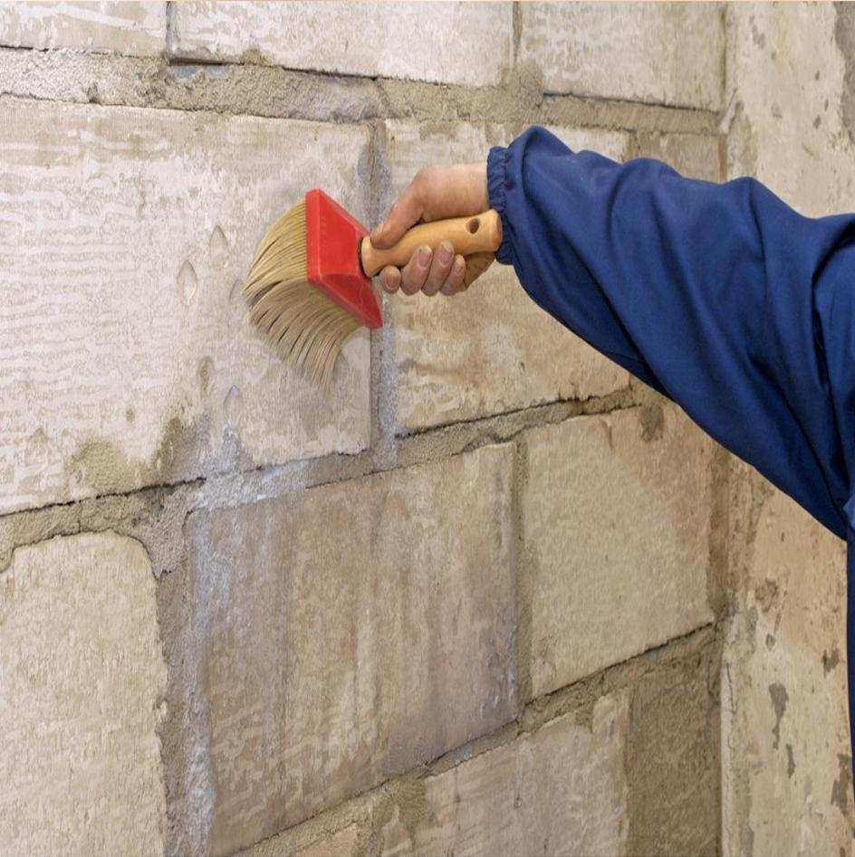
**Выбоины и кромки старой штукатурки надо хорошо смочить водой. При недостаточном смачивании кромок между старой и новой штукатуркой образуются трещины.**
