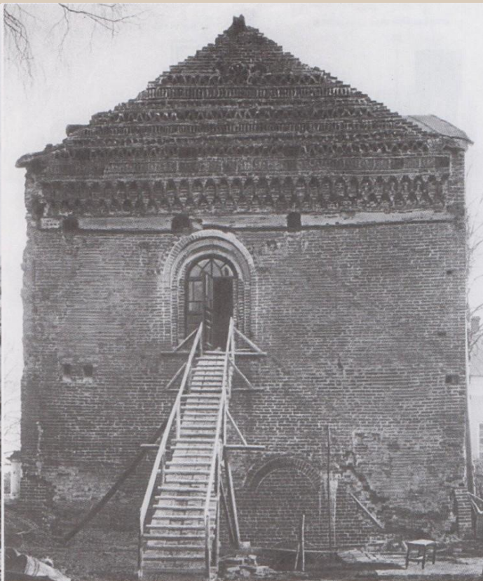
Северный фасад во время реставрации
