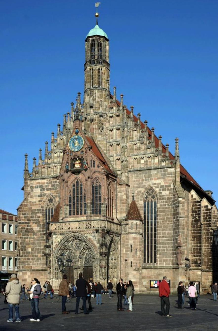
Церковь Фрауенкирхе. г. Нюрнберг
