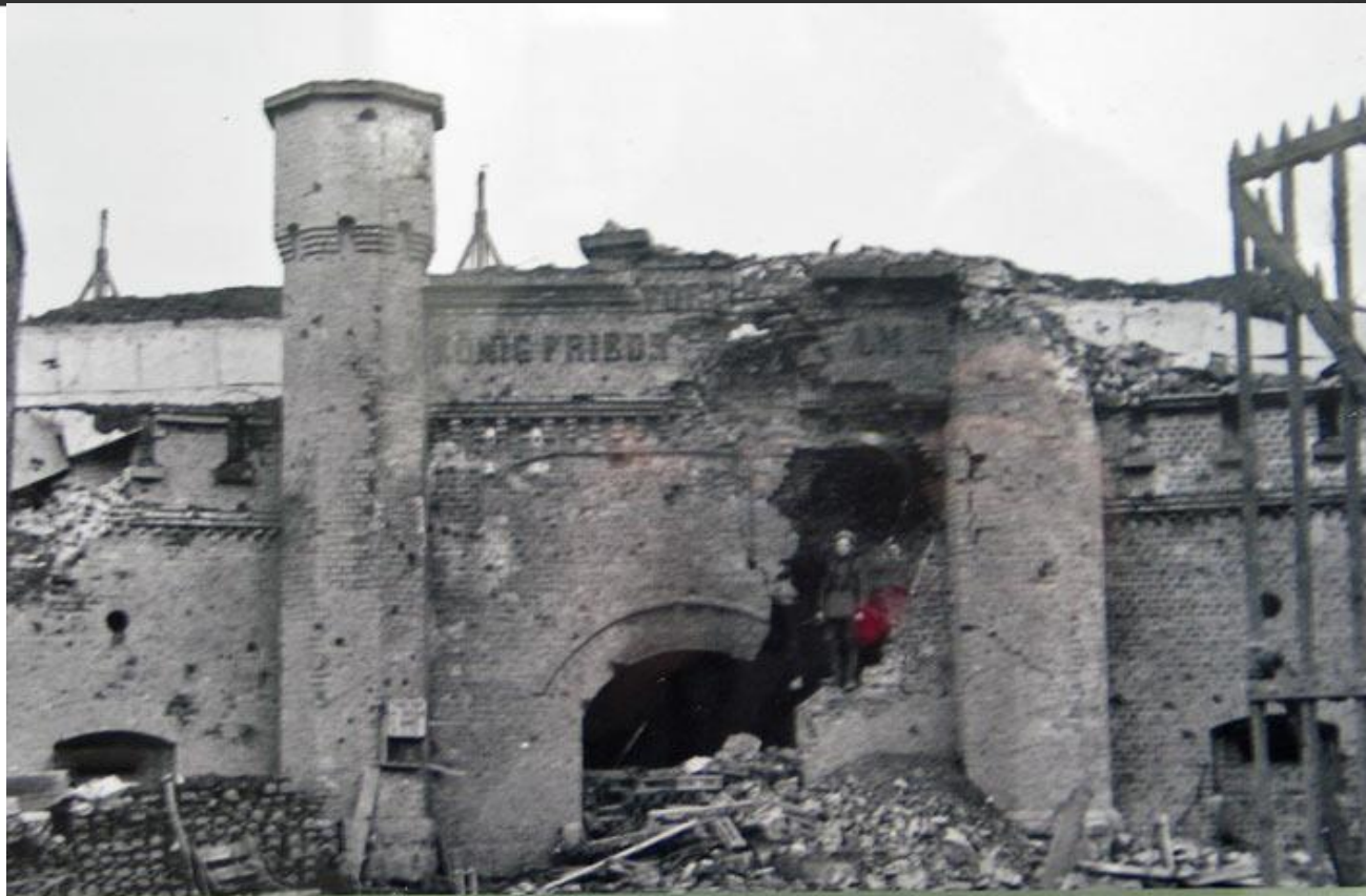
У входа в тыльную часть форта № 5 после боёв. г. Кёнигсберг. Апрель 1945 год.
