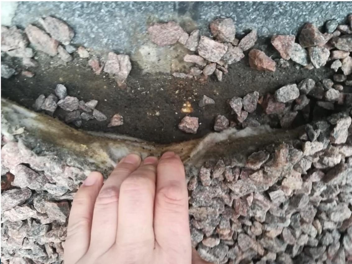
На данных фото мы видим, что ливнесточная воронка сухая, а под геотекстилем стоит вода. Это означает, что на кровле ресепшн есть проблема с разуклонкой для отвода воды. Чтобы провести полное обследование необходимо снять защитный слой из гравия и геотекстиля.
