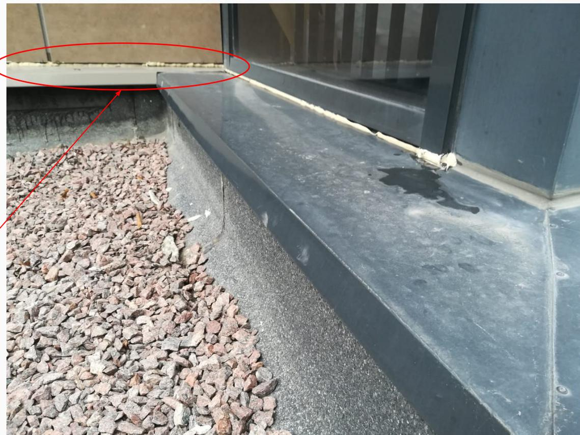
Использованная технология не верна, проблем с протечками не решает. Закрывать отверстия вентилируемого фасада нельзя. Кроме того герметики быстро теряют свои свойства при воздействии ультрафиолета.
