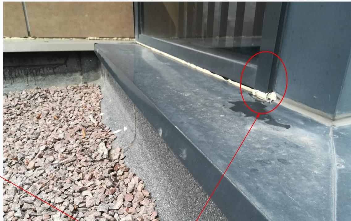
На данных фото мы видим, что на стойках фасадного остекления есть разрывы, в которые возможны затекания воды. При этом выход воды по стойкам фасадного остекления внизу закрыт герметиком. Под стойками фасадного остекления обязательно должны быть отверстия для выхода воды. В результате этого вода может попадать под гидроизоляцию и вытекать в помещении.
