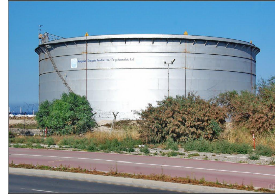
з 01.01.2019 резервуар > 20000 куб.м.
