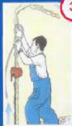
Закладывание труб в штробы
