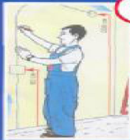
Разметка стен
