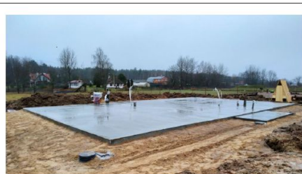
Фото №5 фундамент с коммуникациями
