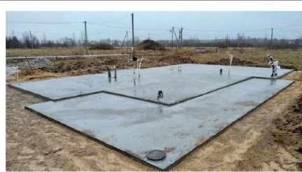
Фото №7 фундамент с коммуникациями
