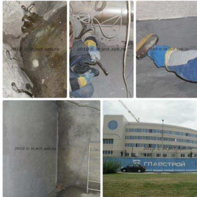
Компания «Тетра Строй» проводила работы по гидроизоляции, восстановлению бетона и ремонту швов на объекте Лечебно-диагностический комплекс «ЛДК» МЧСУФСБ по СПб и Л.О.
