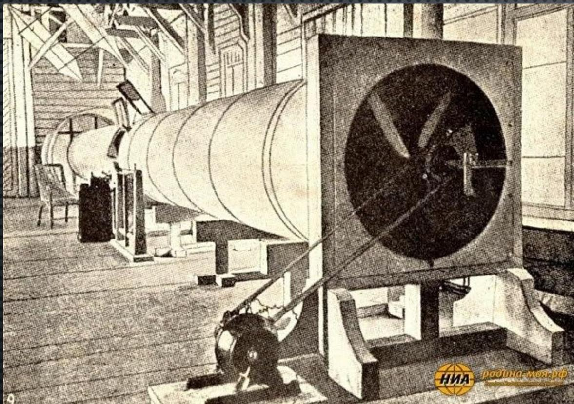
Ученый интересовался устройством аэроплана: изучая его конструкцию, он предложил улучшить его аэродинамические показатели путем создания убирающихся внутрь корпуса шасси в противовес стационарным. Циолковский создал первую в России аэродинамическую лабораторию, где изучал действие воздуха на движущиеся объекты в атмосфере. Его разработками воспользовался другой выдающийся российский учёный Николай Жуковский, который построил свою аэродинамическую трубу.
