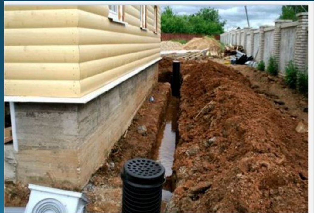
Так выглядит система вертикального дренажа
