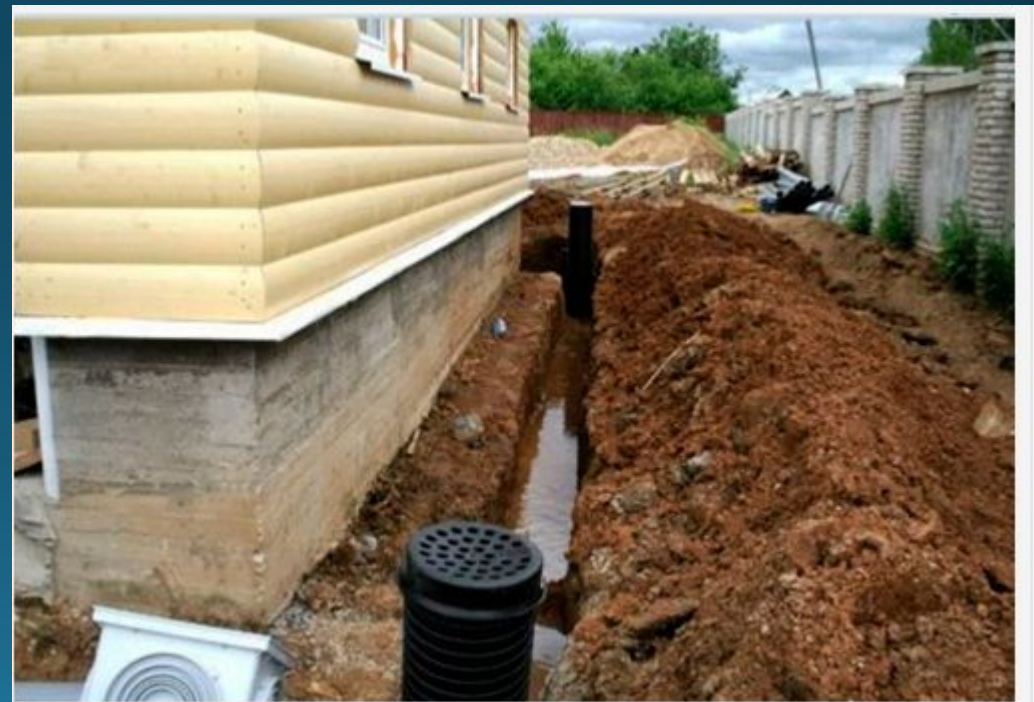
Так выглядит система вертикального дренажа
