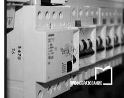
ОСНОВЫ ЭЛЕКТРОСНАБЖЕНИЯ ОБЪЕКТОВ ОТРАСЛИ Сивков А.А., Сайгаш Д.Ю.
