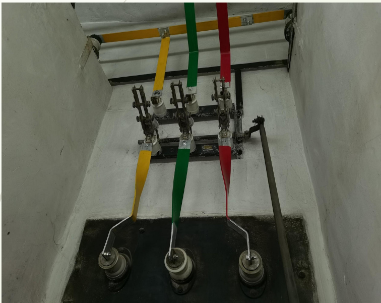
Замена трансформаторов тока на Ф6
