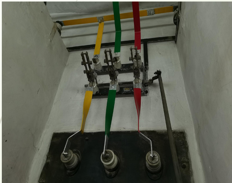
Замена трансформаторов тока на Ф6
