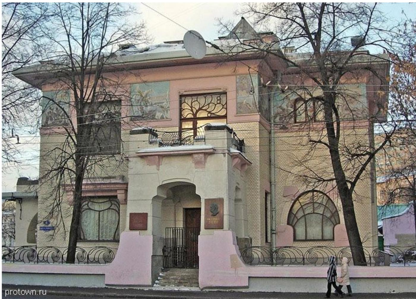
В особняке Рябушинского этот принцип проведен последовательно и целенаправленно. Каждый большой объем в общей композиции получает свое воплощение вовне. Горизонтальные членения, отмеченные наличниками окон, завершением крылец, карнизами крыш, проходят на разных уровнях; формы оконных проемов различны не только на разных этапах, но и на разных фасадах; сами эти фасады при единстве стиля решительно отличаются друг от друга.
