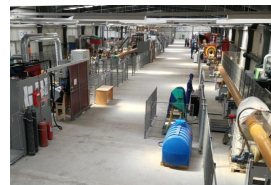
Цех сборки двухтрубных плетей, неразрушающего контроля и нанесения покрытий на стыки, Актау
