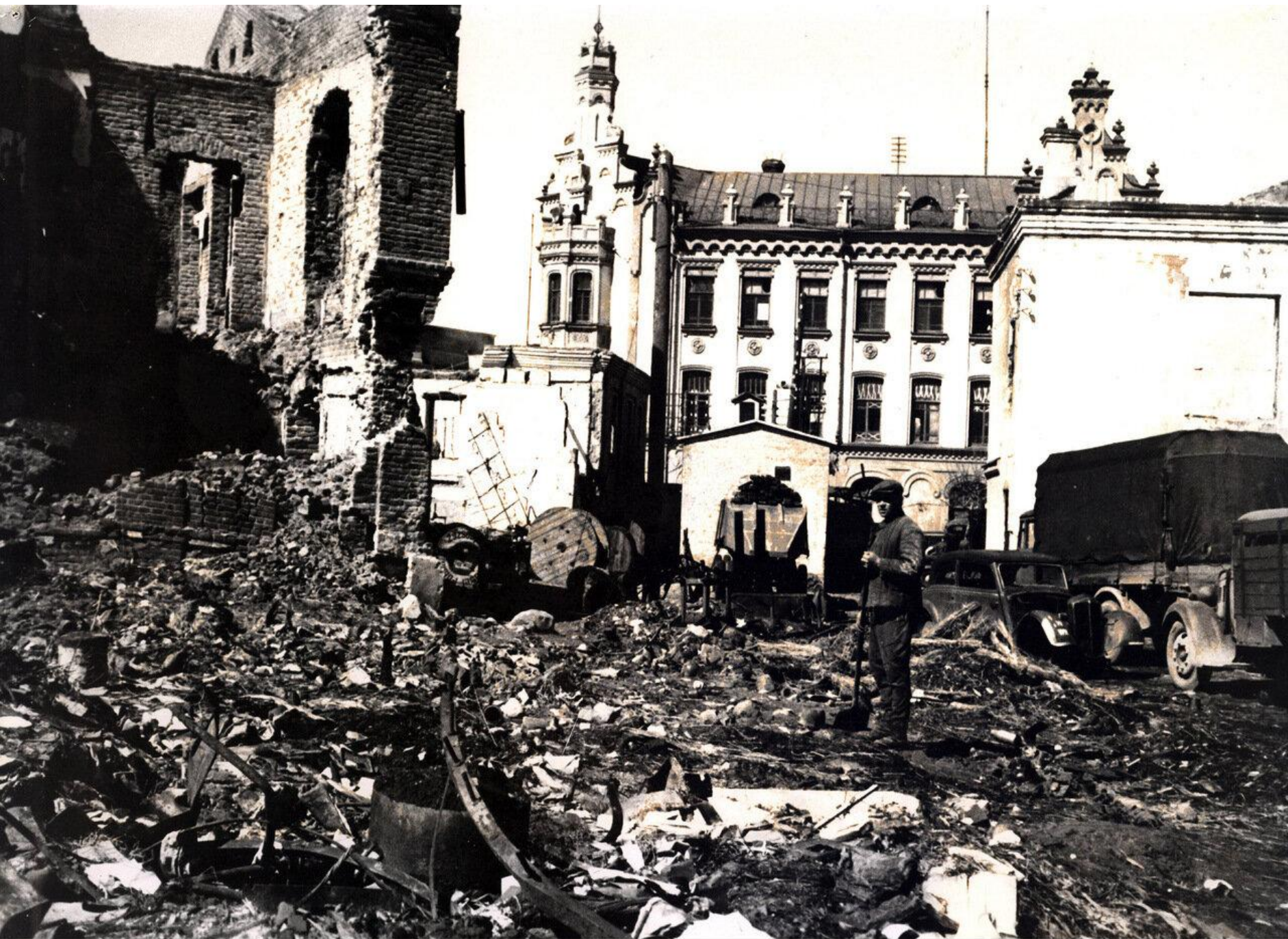
Взрушения у здания Благочинства (иначе - гостиница "Центральная")
