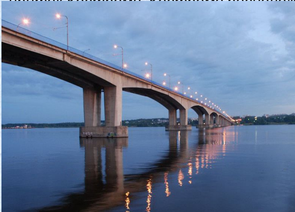
Автодорожный мост через реку Волгу протяженностью 1236 м.
