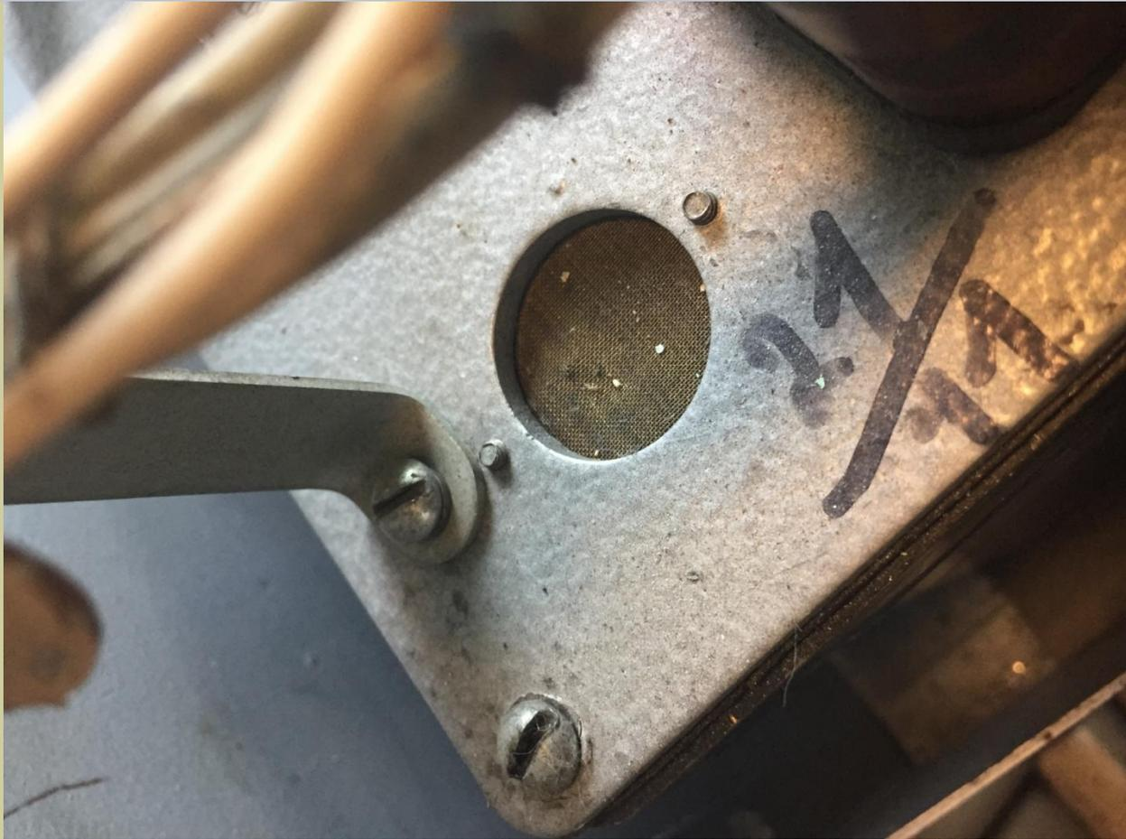
Не соблюдение требований по содержанию аппаратуры ЖАТ в чистоте, ведёт к нарушению её нормальной работы. Попадание пыли и посторонних частиц сквозь вентиляционное отверстие КПТШ увеличивает риск заклинивания роликовых подшипников и возникновения переходного сопротивления контактов.
