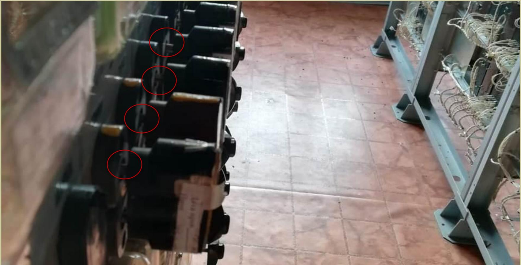
Неплотная установка предохранителей в разъём увеличивает риск потери контакта, а так же не обеспечивает замыкание сигнальных контактов при выходе бойка предохранителя из корпуса, при его перегорании.
