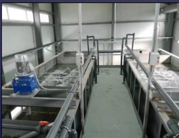
Установка биологической очистки сточных вод, 100 м 3 /час
