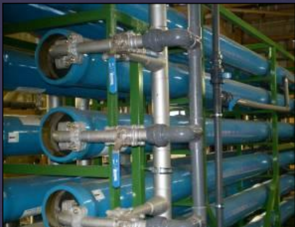
Установка обратноосмотическая, 15 м 3 /час,
