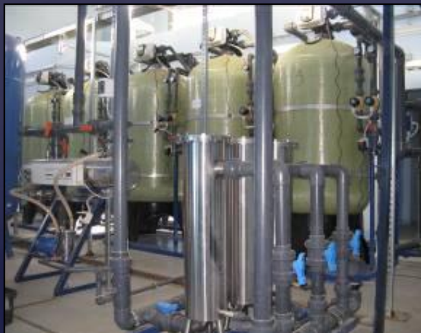
Установка обезжелезивания 100 м 3 /час, пос. Балакирево,
