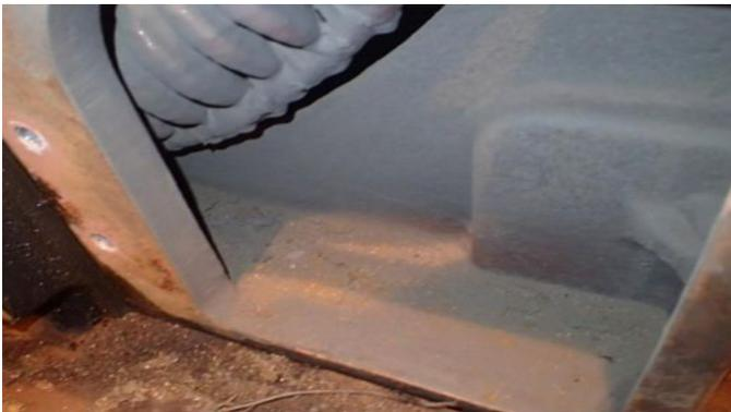
**Рисунок 3 – Загрязнение клеммовой коробки**
