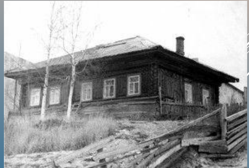
«Зимний» дом С.Я. Проломкина по улице Нагорной.
