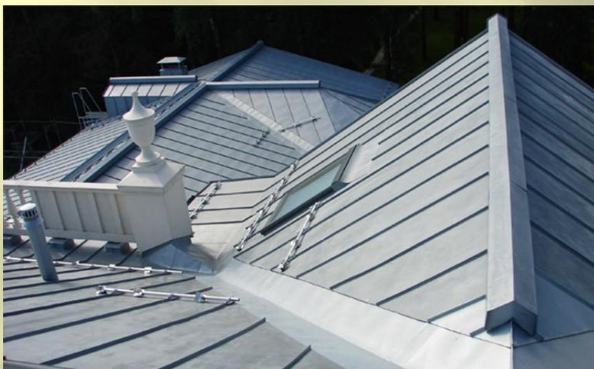
ЦИНК - применяется для кровельных покрытий, карнизов, водосточных труб.
