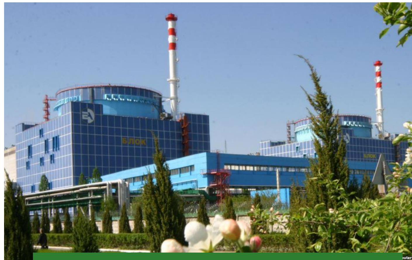
Хмельницька АЕС (2 атомні енергоблоки)
