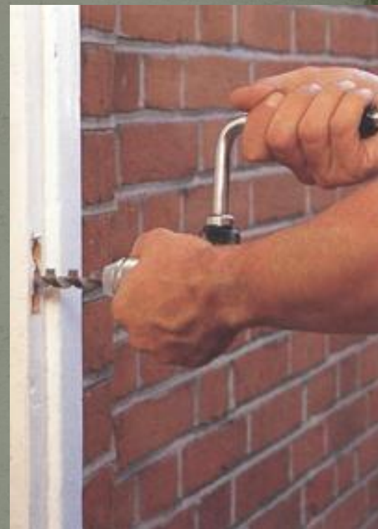
ВЫСВЕРЛИВАНИЕ ГНЕЗДА ПОД ЗАСОВ
