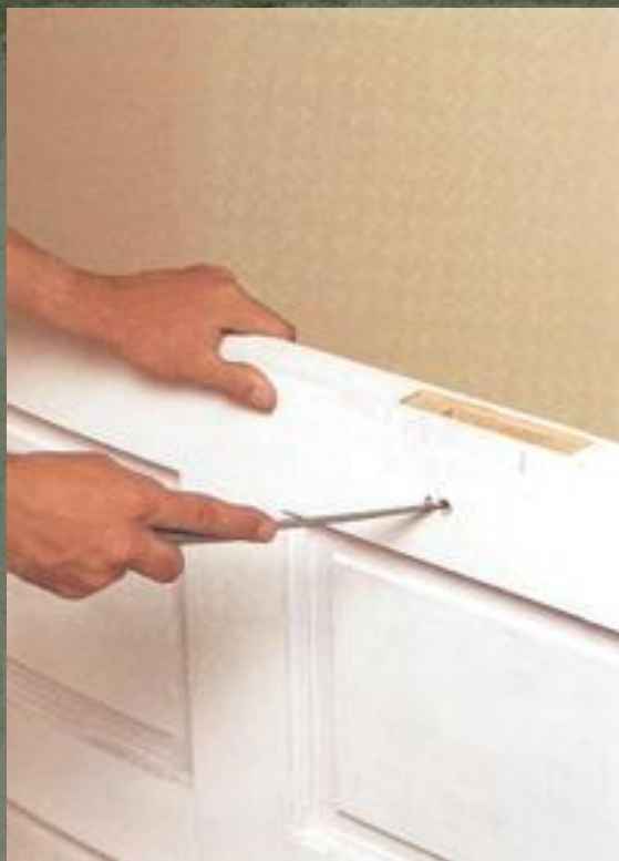
РАЗМЕТКА ОТВЕРСТИЯ ПОД ГНЕЗДО
