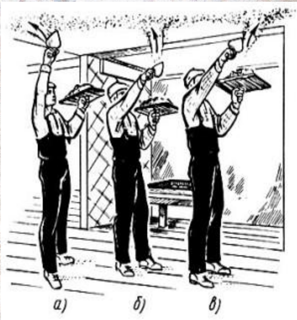
Набрасывание раствора штукатурной лопаткой на потолок: через голову, б — над собой, в — от себя
